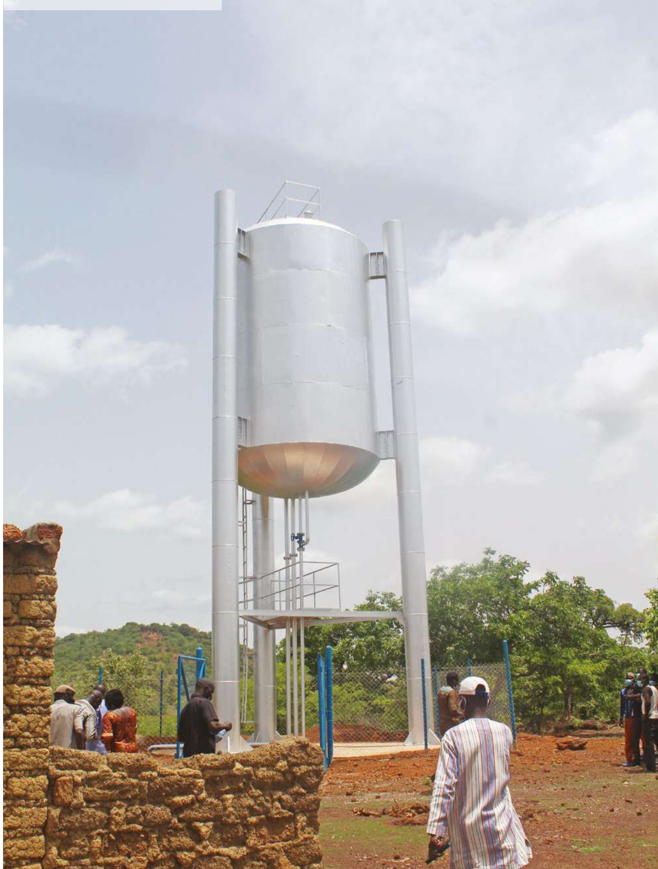
Chateau d'eau d'une capacité de 80 m 3
